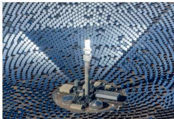
Şəkil 5. İstilik enerjisinin xörək duzu vasitəsi ilə saxlanması.
