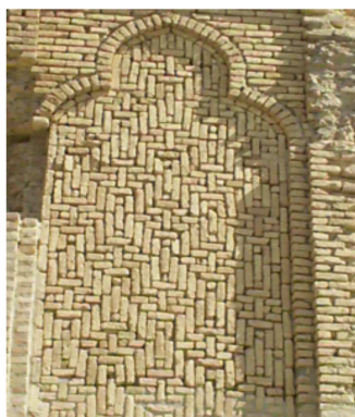
Şəkil 2. Qoşa minarənin ön fasadı “Süls” xətlə üzərində hörgü quruluşu.
