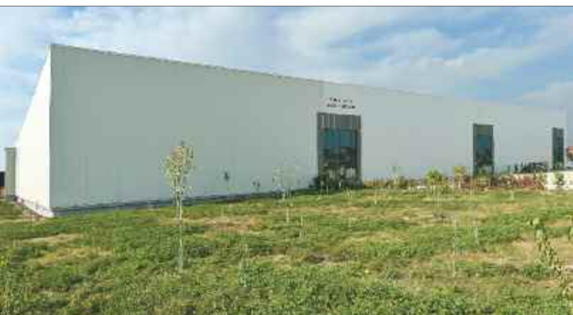
Naxçıvan şəhərində "Cahan Sənaye Kompleksi" Məhdud Məsuliyyətli Cəmiyyətinin istilik panelləri və dam örtükləri istehsalı müəssisəsi
