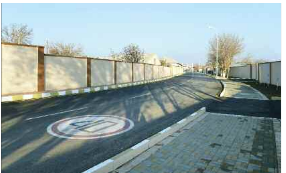
Naxçıvan şəhərinin Qaraxanbəyli kəndində avtomobil yolu
