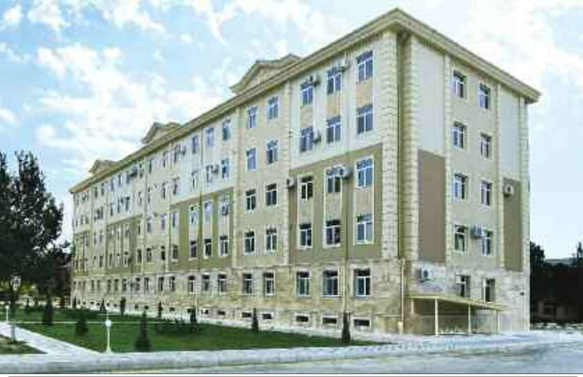
Naxçıvan şəhərinin "İstiqlal" küçəsində 79 nömrəli yaşayış binası
