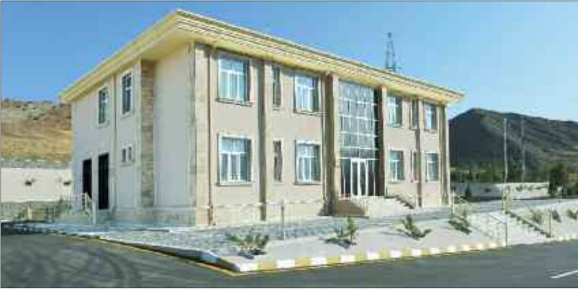
Şahbuz Rayon Elektrik Şəbəkəsinin inzibati binası və "Şahbuz" yarımstansiyası
