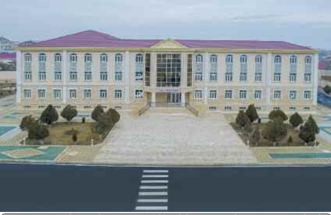
Naxçıvan şəhərində 640 şagird yerlik 3 nömrəli tam orta məktəb
