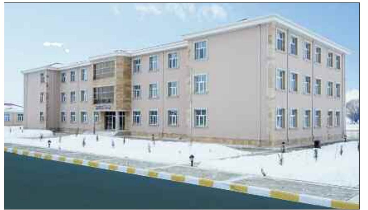
Şərur rayonunun Çəmənli kəndində 380 şagird yerlik tam orta məktəb
