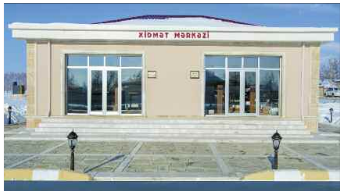
Şərur rayonunun Çəmənli kəndində xidmət mərkəzi
